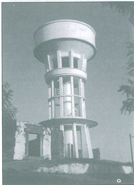
Porta do Castelo e depósito de água
